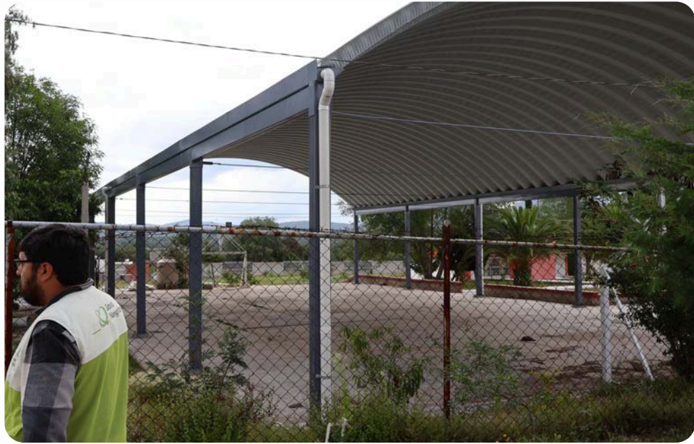
Construcción de techumbre en la primaria Guadalupe Victoria
